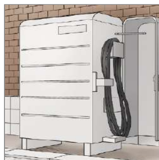
e 電力の確保 V2Hパワーコンディショ ナの設置工事
