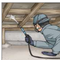
床下の防腐・防 蟻処理
